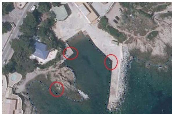
Exemple de reprise portuaire à effectuer
